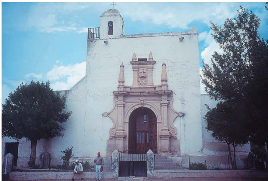
1. Vista general de la fachada, iglesia parroquial, Santa María de Cuevas, Chihuahua. Foto: Libertad Villarreal, 2002.
